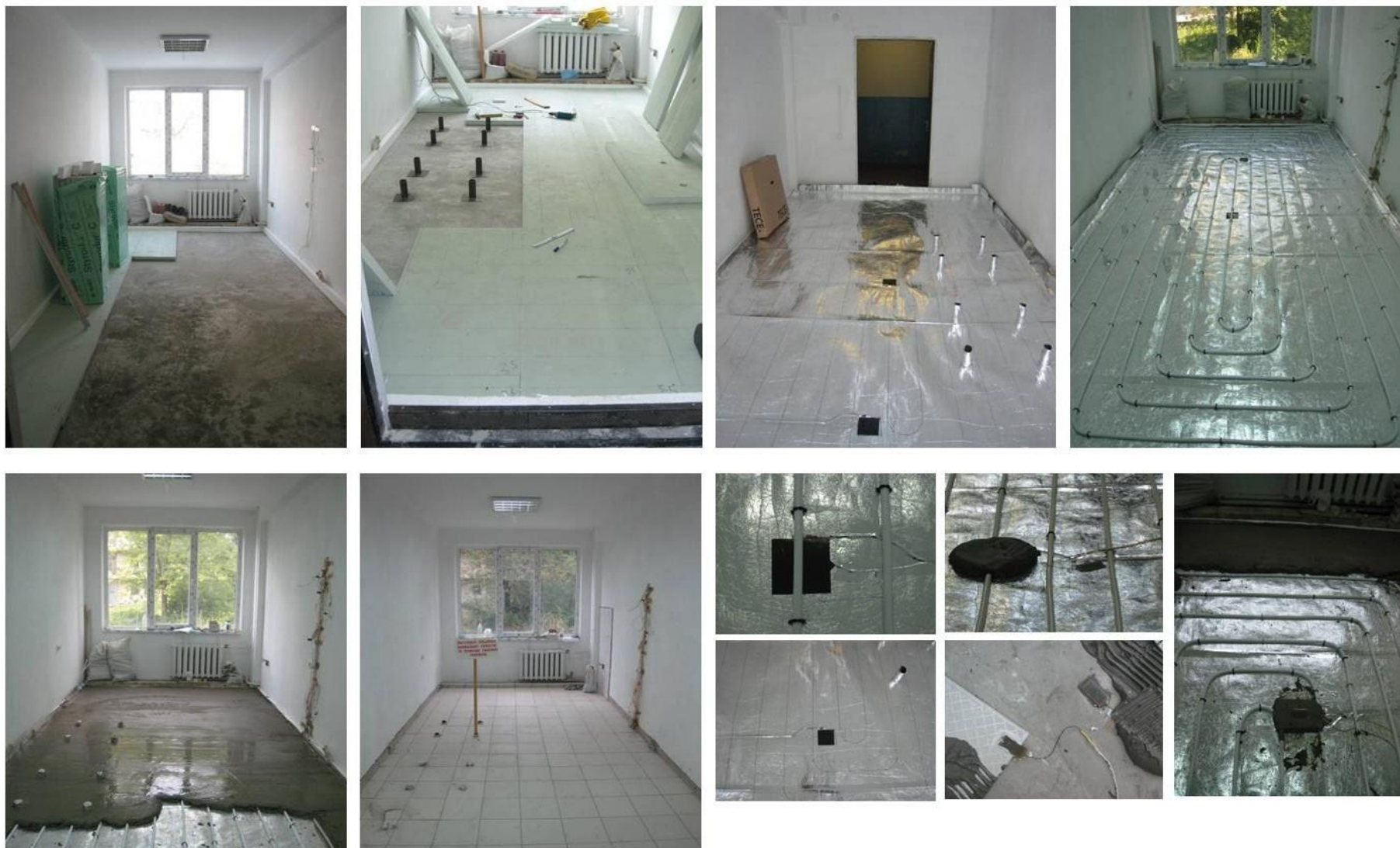
Рис. 4.5. Покрокове створення системи опалення
