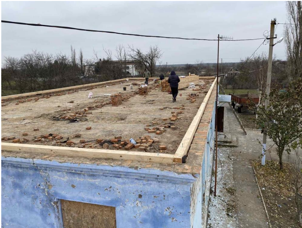
Рис.2.1. Обстеження будівлі ліцею.
