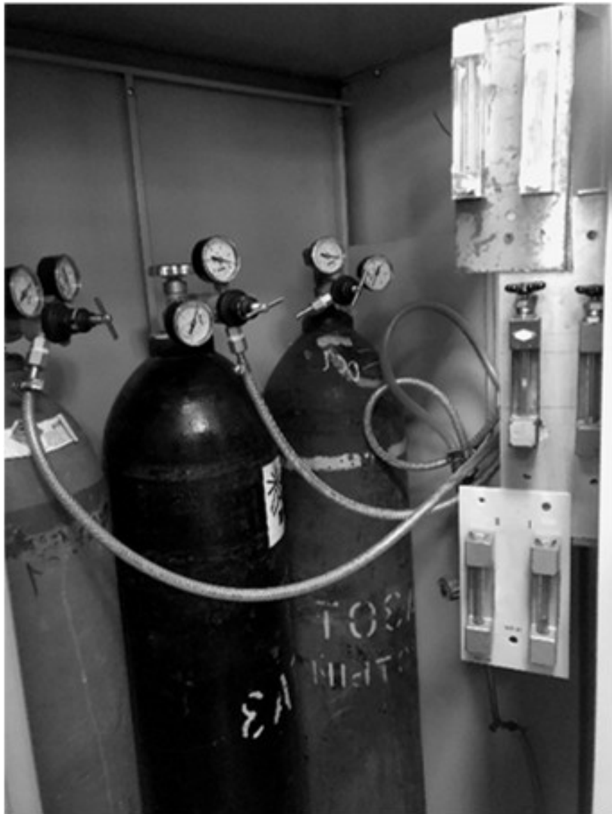
Рисунок 2.3 – Зовнішній вид системи змішування суміші захисних газів
