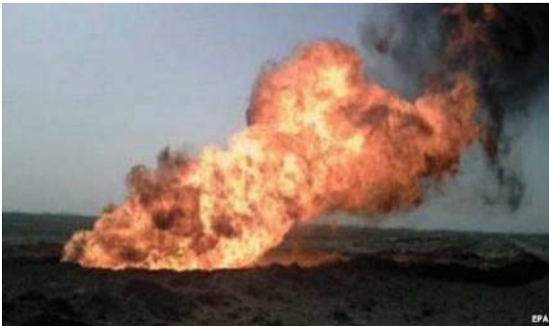
Рис. 1.9. Аварія на магістральному трубопроводі Полтавського регіону
