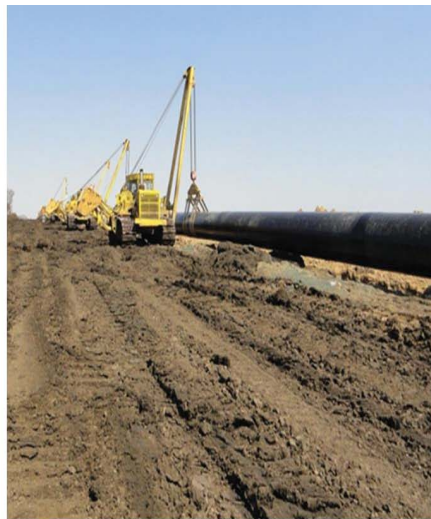
Рис 1.10. Монтаж підземного магістрального трубопроводу
