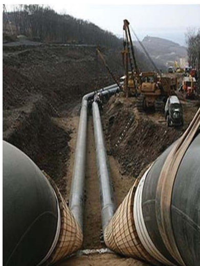
Рис 1.10. Монтаж підземного магістрального трубопроводу
