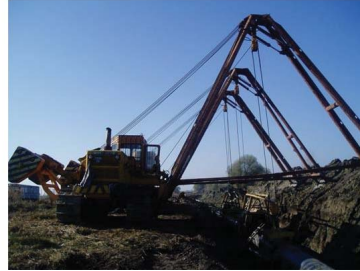
Рис. 1.13. Заміна ізоляції магістрального трубопроводу без припинення транспортування продукту
