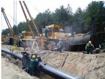
Рис. 1.11. Виконання ізоляції магістрального трубопроводу
