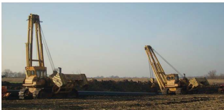
Рис. 1.14. Капітальний ремонт ділянки магістрального трубопроводу із частковою заміною труб
