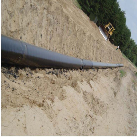
Рис. 1.11. Виконання ізоляції магістрального трубопроводу
