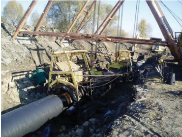
Рис. 1.13. Заміна ізоляції магістрального трубопроводу без припинення транспортування продукту
