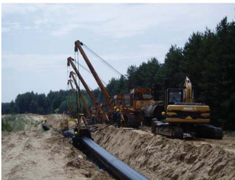
Рис. 1.12. Заміна ізоляції магістрального трубопроводу після припинення транспортування продукту
