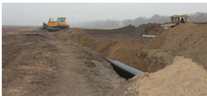
Рис. 4.25. Заміна ізоляції трубопроводу, прокладеного в лесових ґрунтах Полтавської області
