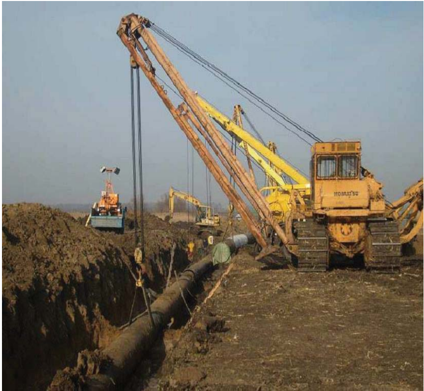
Рис. 2.2. Монтаж нової ділянки магістрального нафтопроводу
