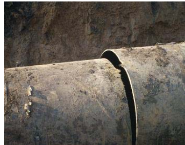
Рис. 1.26. Прояв напружень зрізу труби під час розрізання
