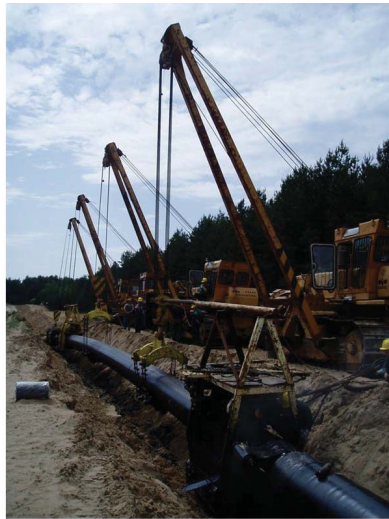
Рис. 1.12. Заміна ізоляції магістрального трубопроводу після припинення транспортування продукту
