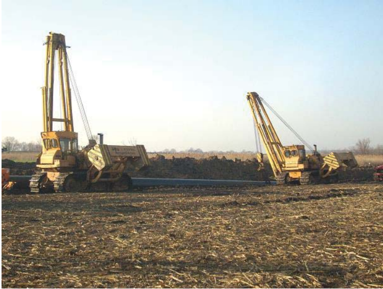
Рис. 1.28. Загальний вигляд процесу капітального ремонту
