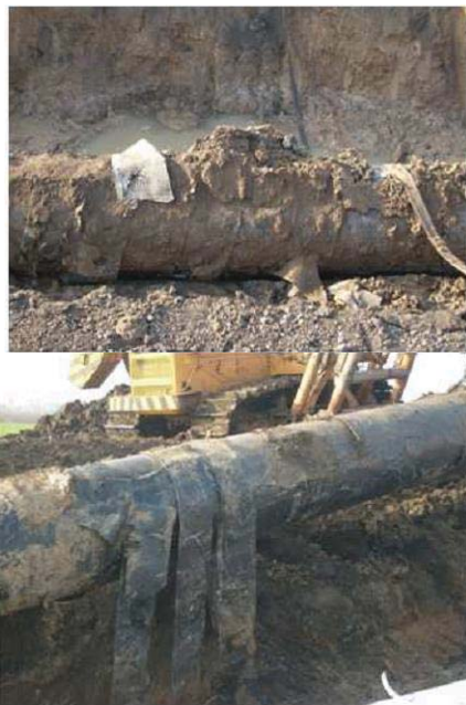
Рис. 1.25. Стан ізоляції заміненої ділянки
