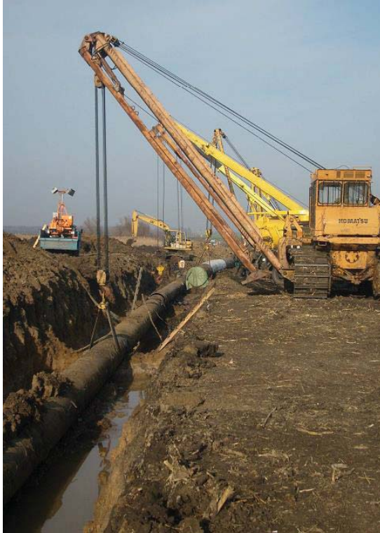
Рис. 1.27. Процес підйому ділянки магістрального трубопроводу для заміни
