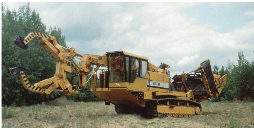
Рис. 1.21. Машина підбивання ґрунту під трубопровід
