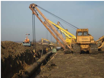
Рис. 1.13. Заміна ізоляції магістрального трубопроводу без припинення транспортування продукту
