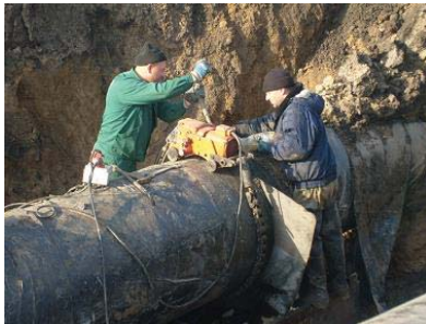
Рис. 1.26. Прояв напружень зрізу труби під час розрізання
