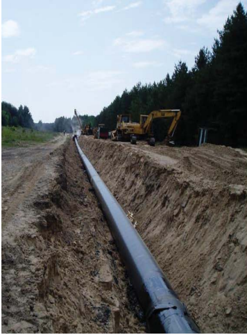
Рис. 1.11. Виконання ізоляції магістрального трубопроводу
