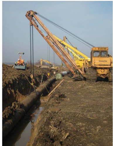
Рис. 1.14. Капітальний ремонт ділянки магістрального трубопроводу із частковою заміною труб
