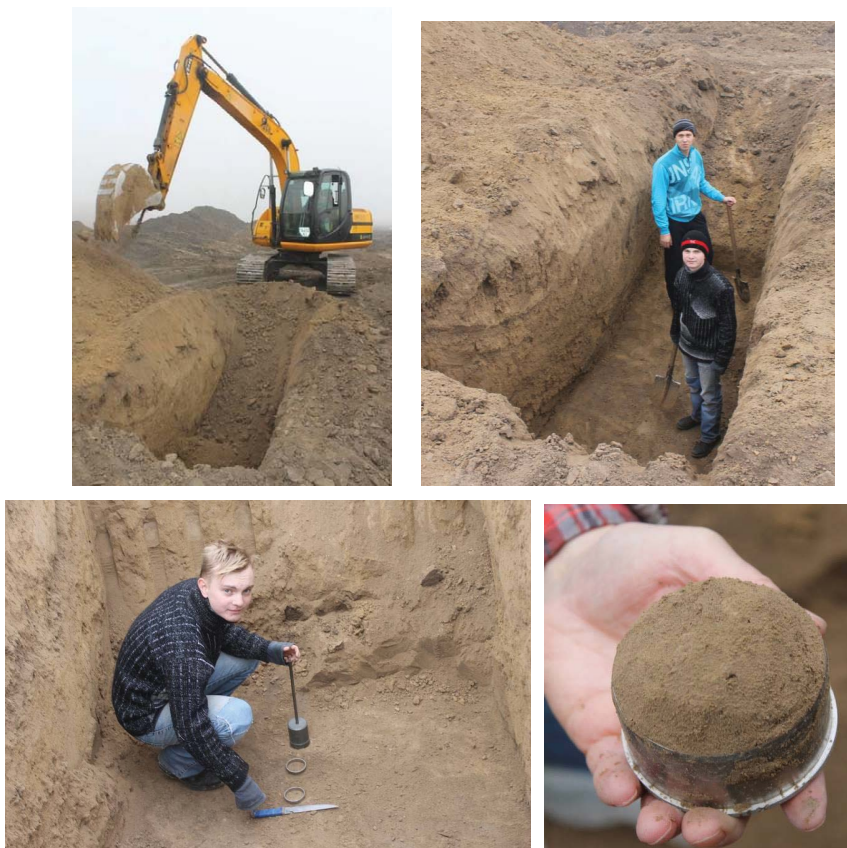
Рис. 4.26. Відбір зразків лесового ґрунту з масиву на трасі трубопроводу
