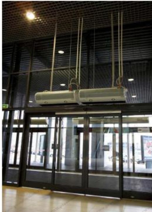
Рисунок 7.1 - Приклад установки повітряно-теплової завіси.
