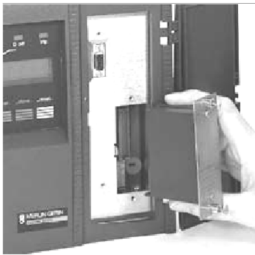
Рисунок 1.3 - Установка змінного в Seram 2000 пульта TSM 2001
