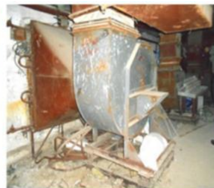
Рис. 1.3. Залишки вентиляційного обладнання припливних систем вентиляції
