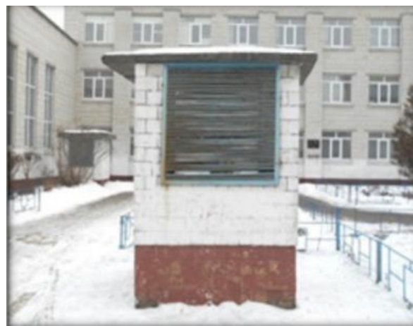
Рис. 1.4. Шахти для відбору зовнішнього повітря
