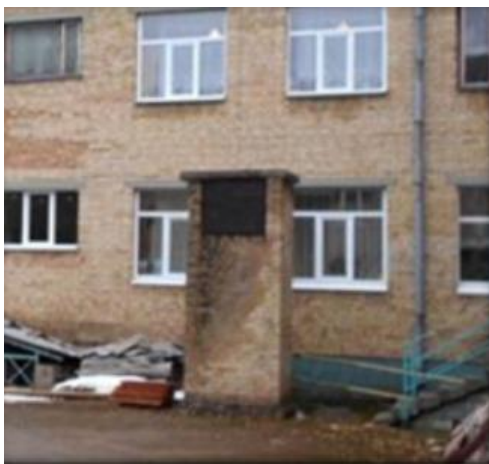
Рис. 1.4. Шахти для відбору зовнішнього повітря
