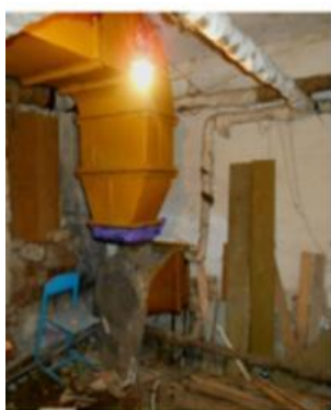
Рис. 1.3. Залишки вентиляційного обладнання припливних систем вентиляції
