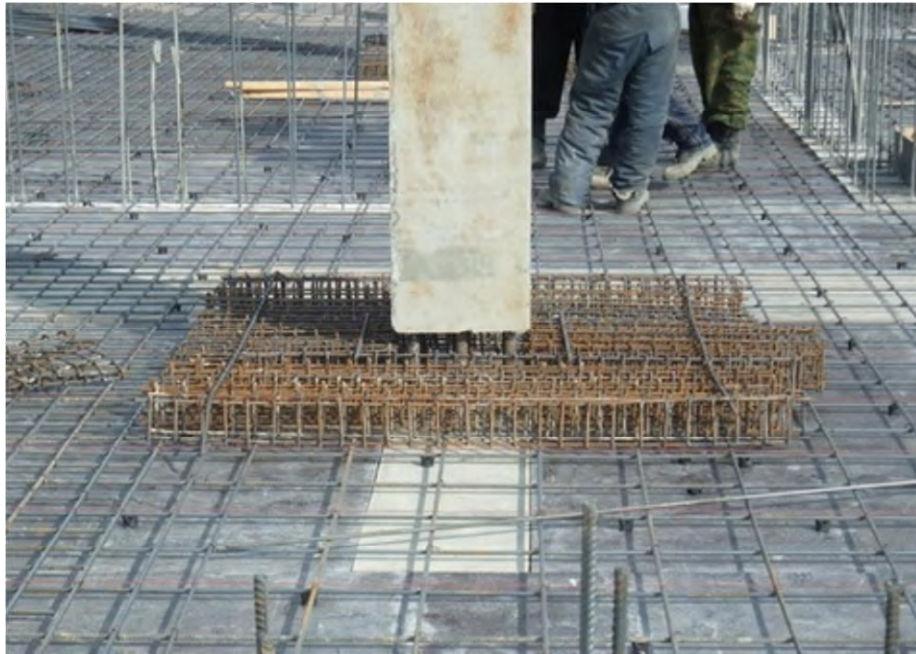
Рисунок 1.3. - Поперечна арматура в області колони безбалкового перекриття
