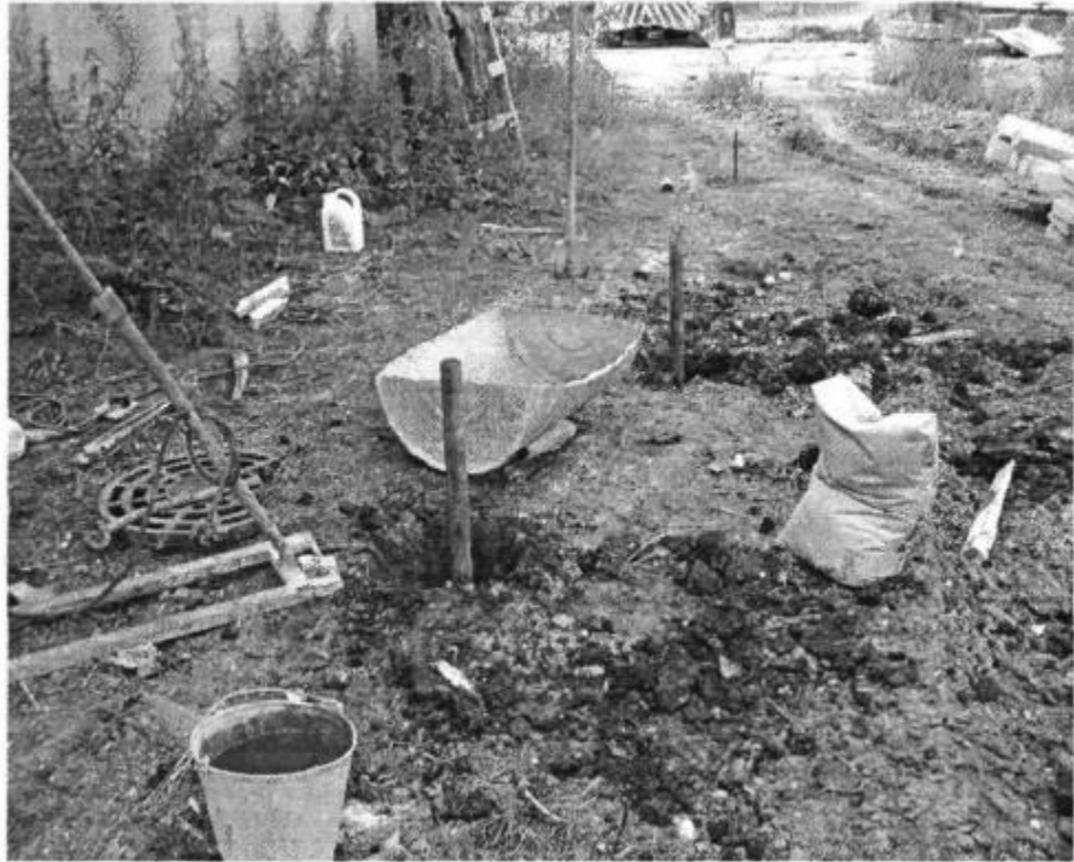
Рис. 3.7. Виготовлення ін'єкційних паль методом манжетної технології
