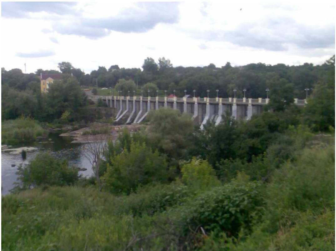
Рис. 2.6. Загальний вигляд МГЕС потужністю 7,5 МВт (м. Корсунь-Шевченківський, Черкаський район, Черкаська область)
