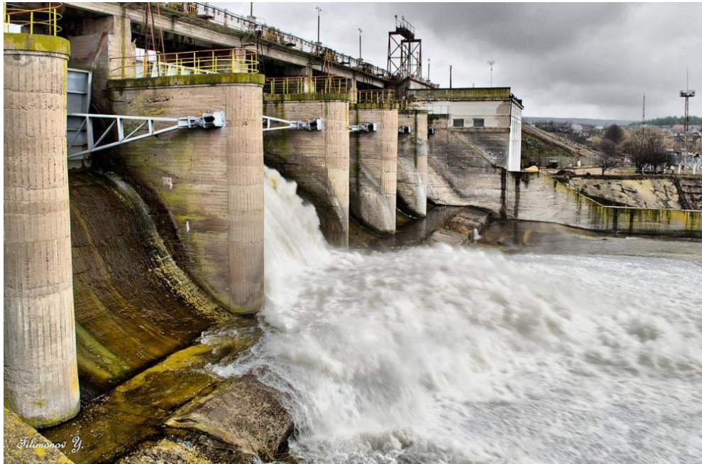
Рис. 2.5. Загальний вигляд МГЕС потужністю 7,5 МВт (м. Ладижин, Гайсинський район, Вінницька область)
