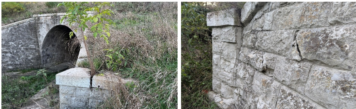
Рисунок 4 — Порось рослин, вихідний оголовок, руйнування кам'яних елементів
