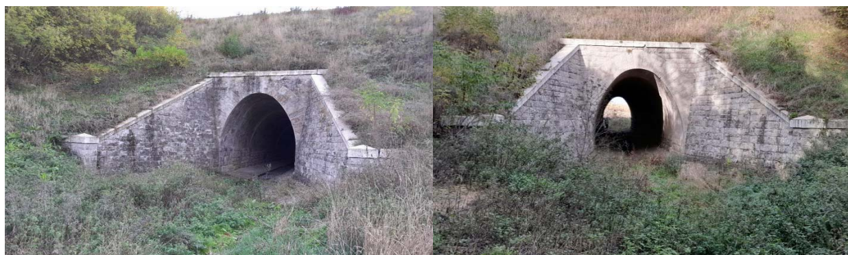
Верхній б'єф, вхідний отвір (ліворуч за ходом пікетажу з/д колії)
