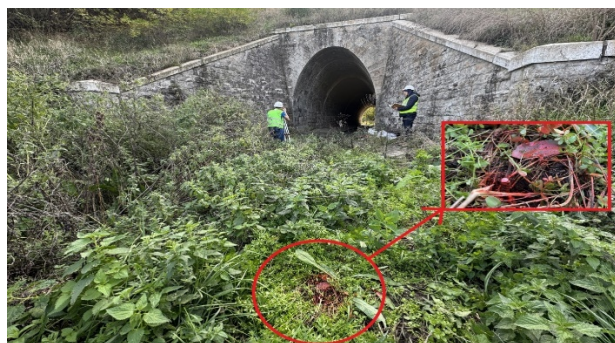
нівелювання зі сторони верхнього б'єфу, репер «RP0»
