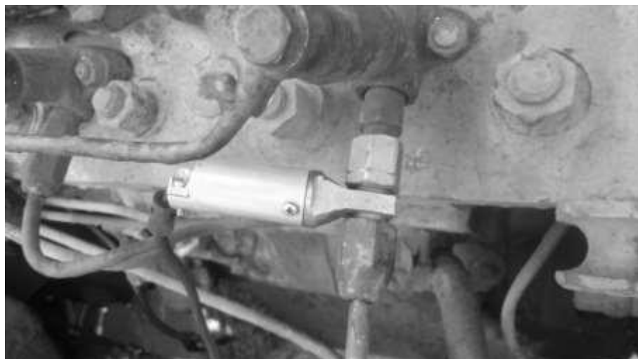
Рисунок 3.21. Встановлення датчика тиску на паливопроводі високого тиску двигуна СМД-62.
