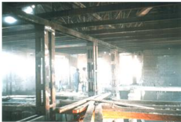
Рис. 4.3 Проведення робіт по монтажу металокаркострою (на задньому плані видно залишки подовжніх стін)
