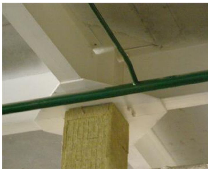
Рис. 4.6 Спирання сталевих балок перекриття на колону
