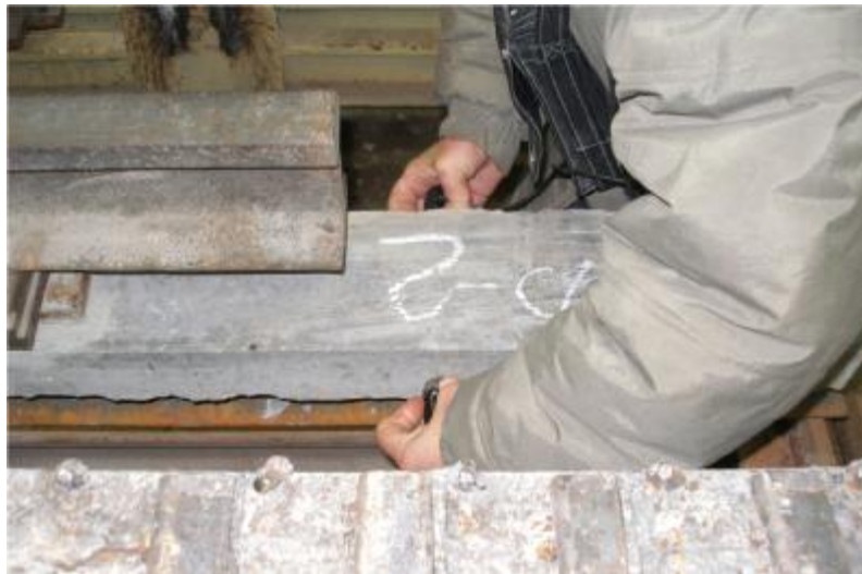
Рис. 2.13. Наскрізне прозвучування залізобетонної плити балки БД- 2
