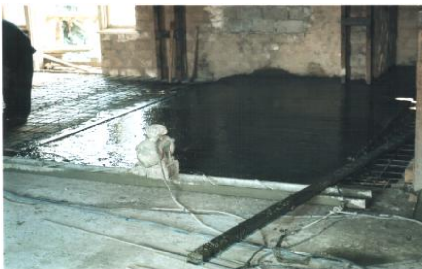
Рис. 4.4 Бетонування залізобетонної плити
