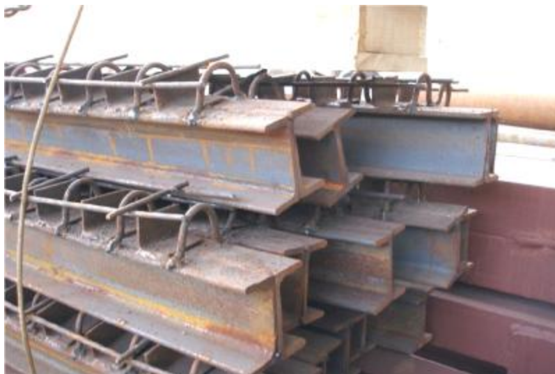
Рис. 2.2 Вид виготовлених сталевих балок з привареними упорами, петлевими анкерами і арматурою
