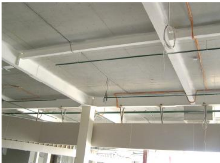
Рис. 4.5 Загальний вигляд фрагмента сталезалізобетонного перекриття
