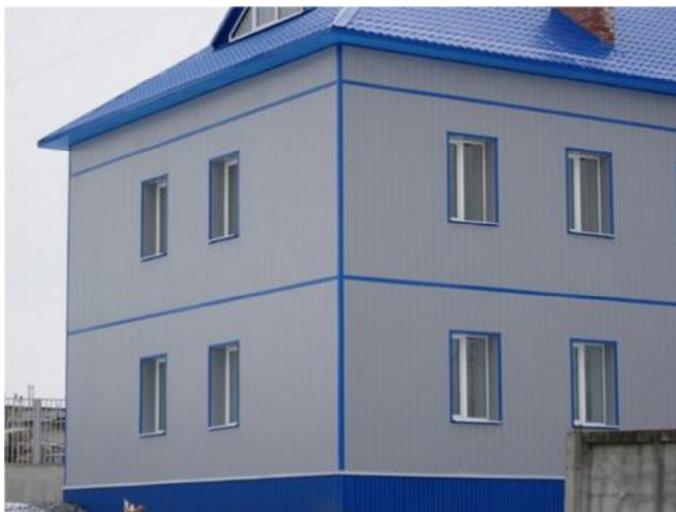
Рис. 1.2. Застосування сандвіч-панелей в будівництві
