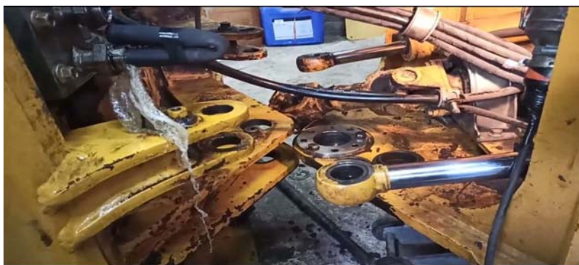
Рисунок 1 – Ремонт шарнірного з'єднання фронтального навантажувача
