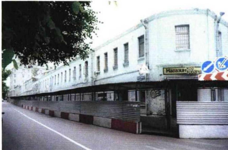
Рисунок 1.1 – Перехрестя по вул. М. Полянка
