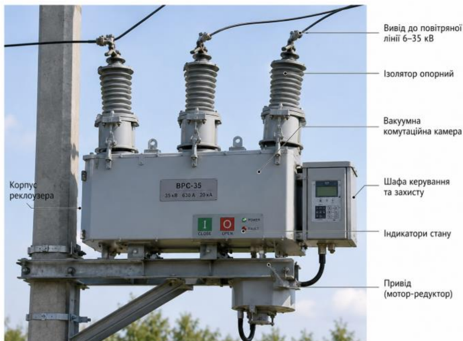
Рисунок 7. 10 - Реклоузер (вимикач) вакуумний
