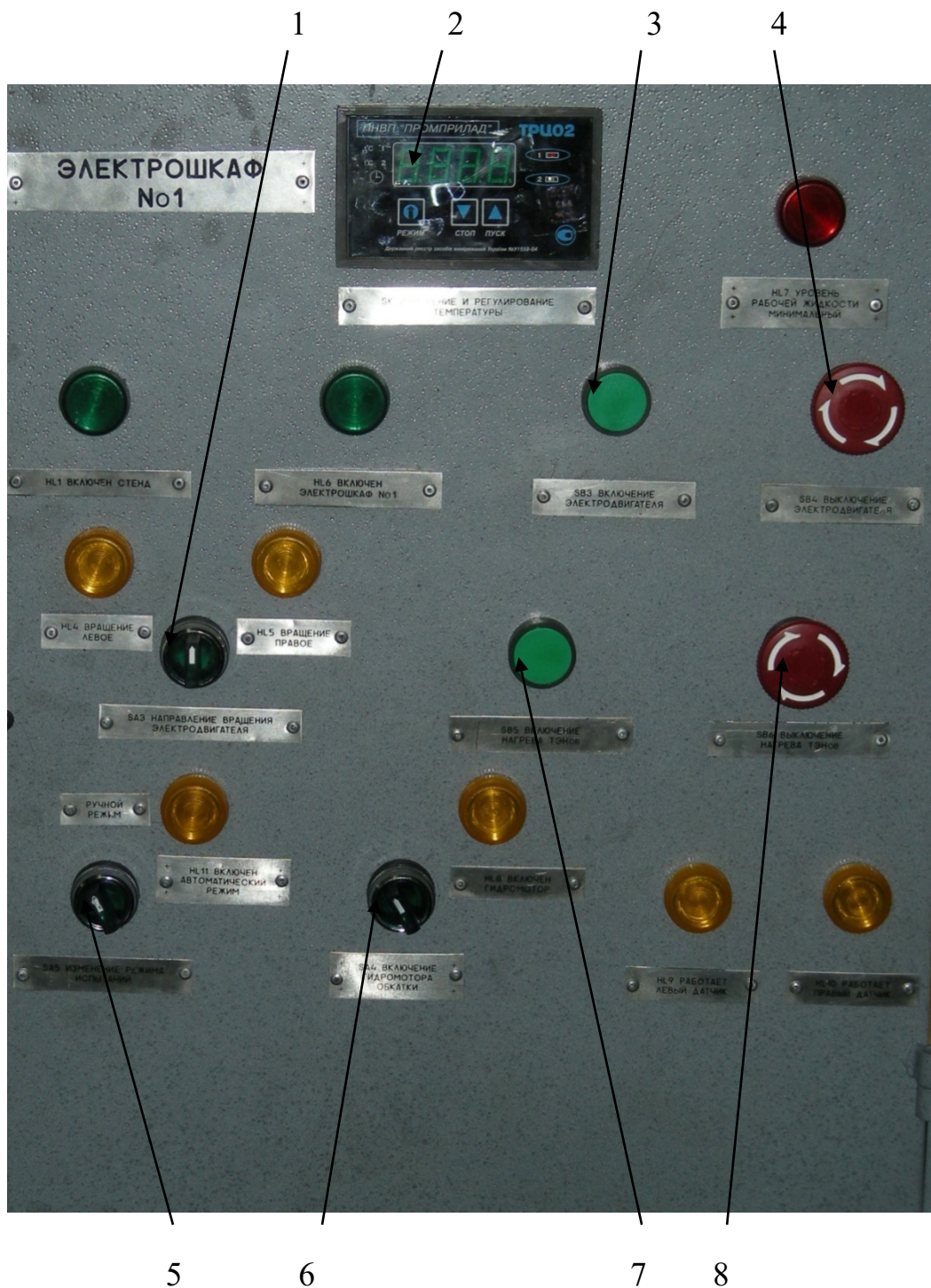
Рис. 3.2.2.4 Конструктивне виконання електрошкафа
