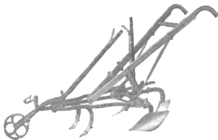
Рис. 2.6. Кінно-ручний культиватор міжнародної компанії жниварських машин (Німеччина)
