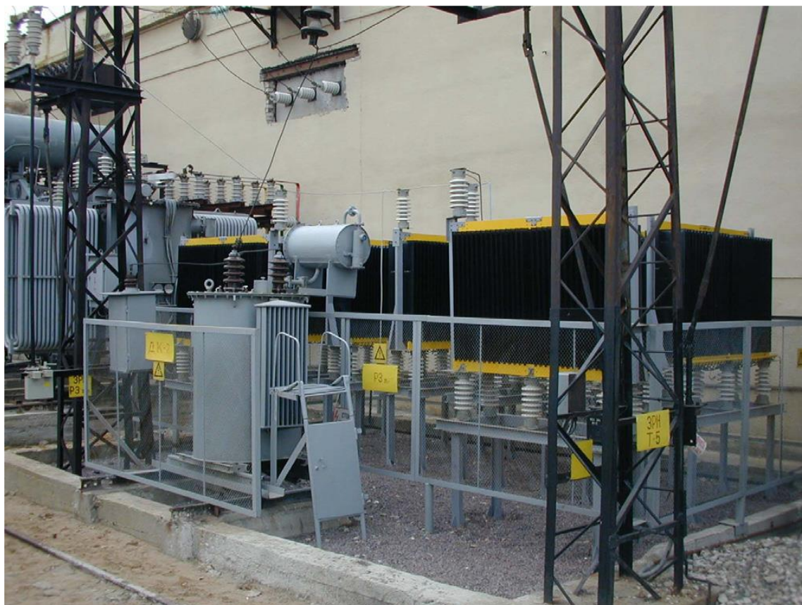
Рис. 3.12. Резисторы РЗ-4000-102-35 на ВРП-35 кВ
