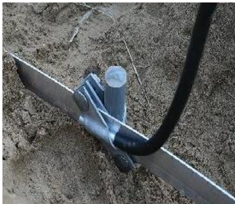
Рис. 4.3. Зовнішній вигляд заземлювача
