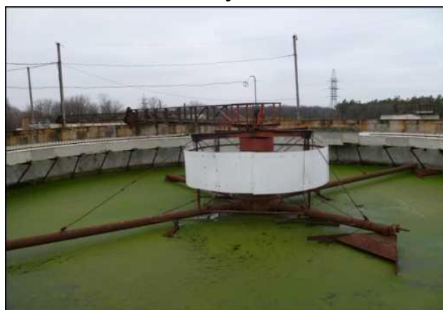
Рисунок 2.5.6 – Відстійник, виведений з експлуатації
