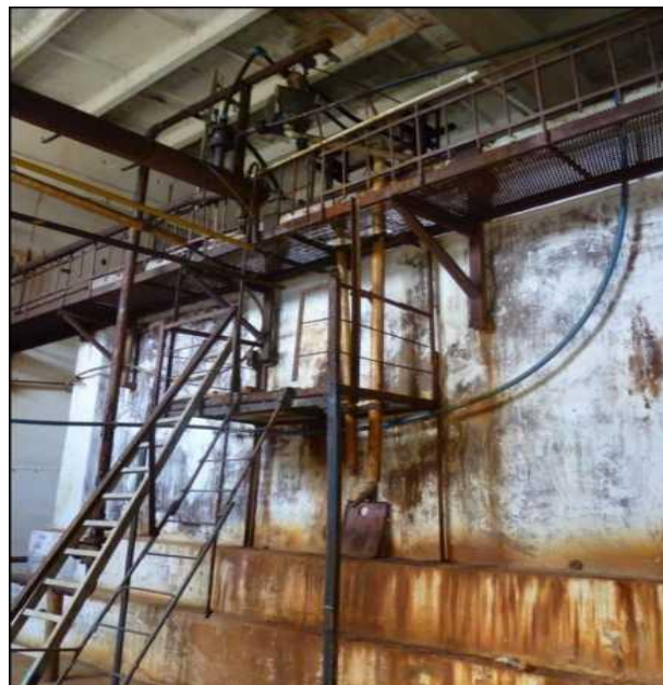
Рисунок 2.3.2 – Потужна корозія
