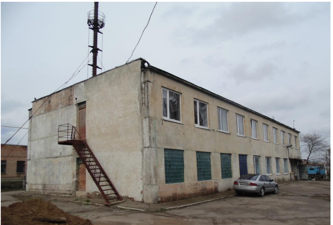
Рисунок 3.2.1 - Зовнішній вигляд адмінбудівлі КНС.
