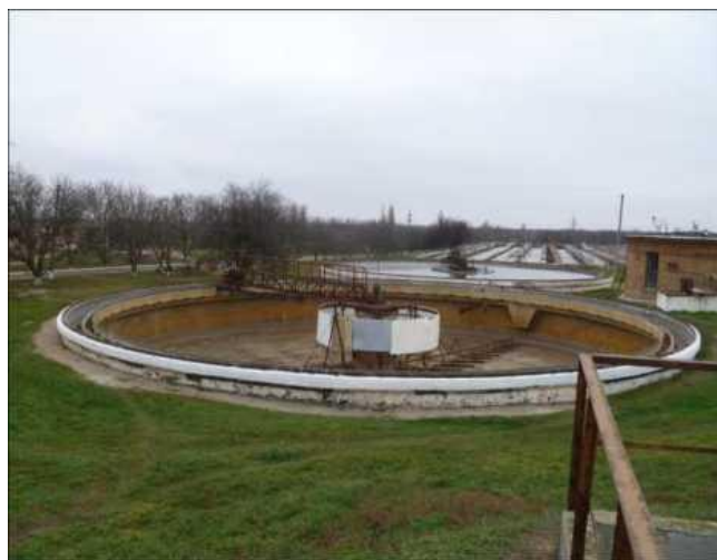
Рисунок 2.5.4 – Відстійник, виведений з експлуатації
