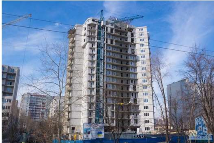
Рисунок 2.14 – Зовнішній вид 16-ти поверхового житлового будинку під час провадження будівельно-монтажних робіт [ 1 ].
