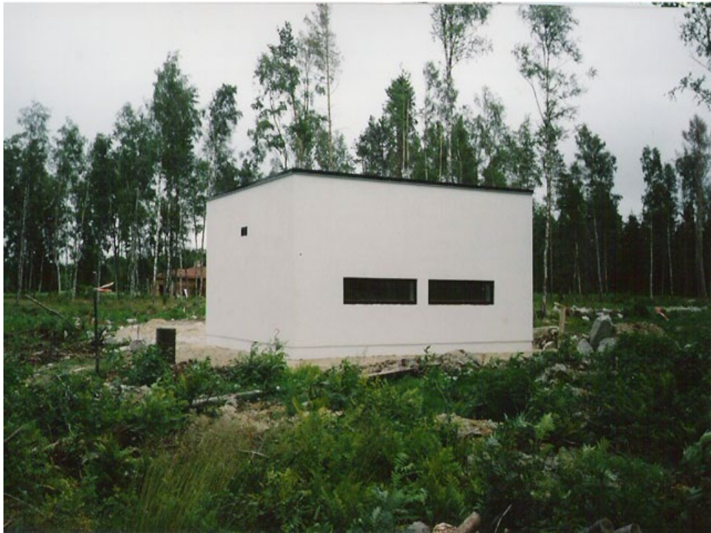
Рис. 1.4. Зовнішній вигляд будівлі насосної станції котеджного містечка.
