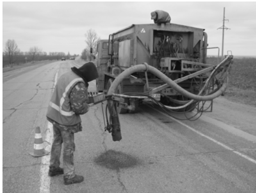
Рисунок 7 – Машина ямкового ремонту УЯР-01 на базі автомобіля КАМАЗ
